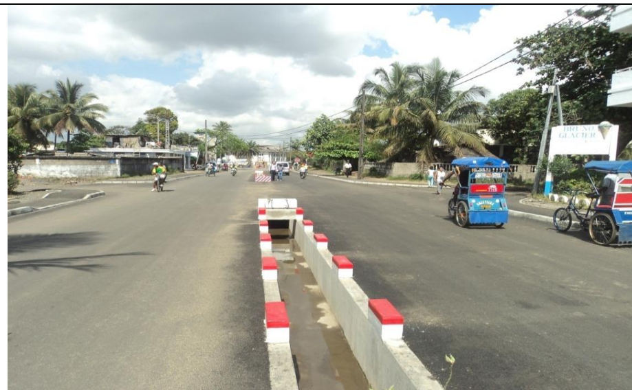
RUE DE TOAMASINA
